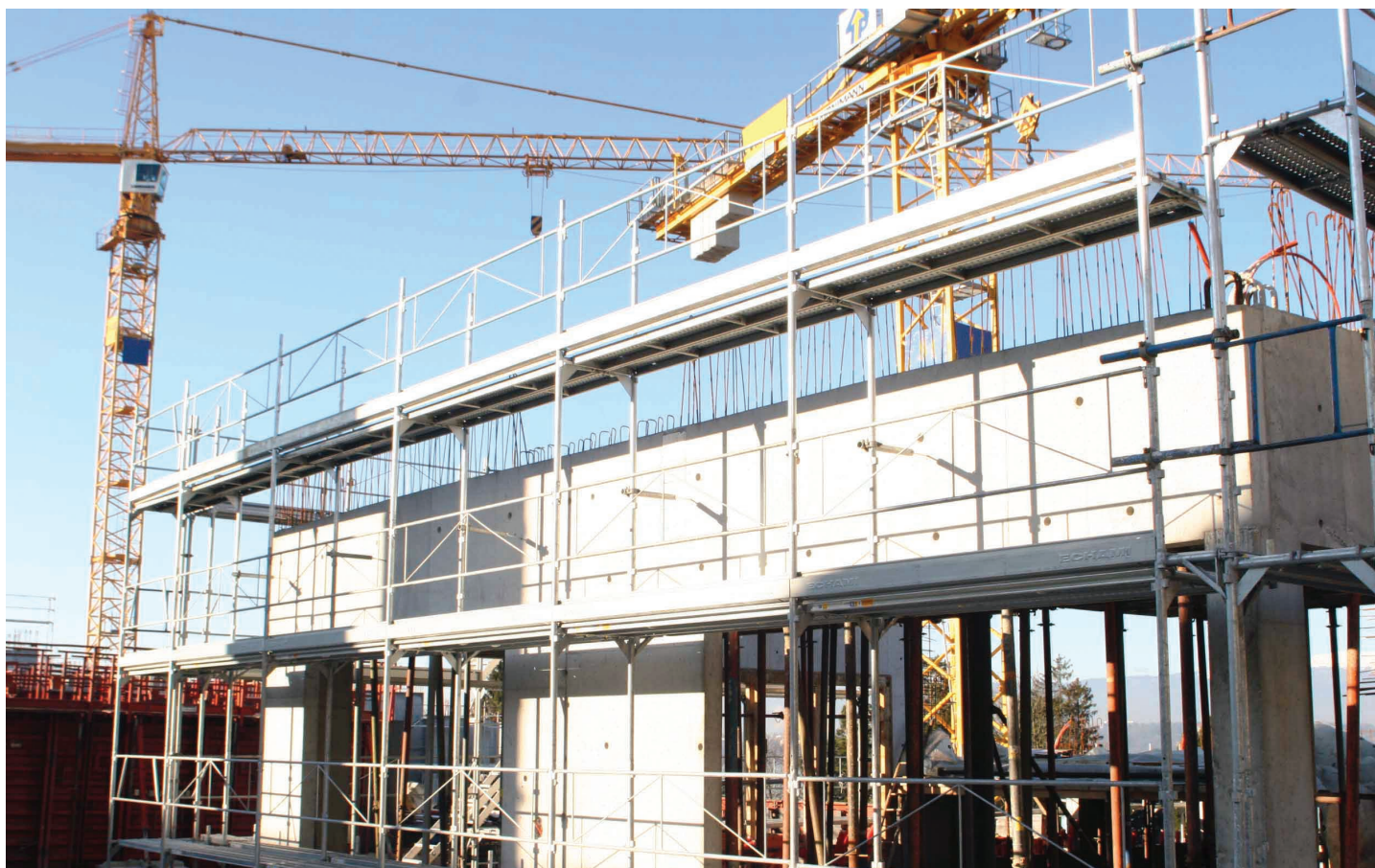
Une construction en cours de réalisation
