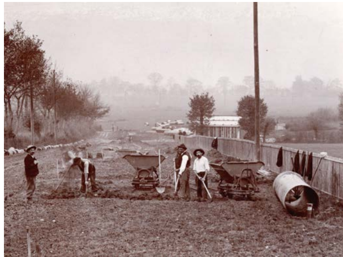
Nouvelle Usine à Gaz de Châtelaine: commencement de la construction de la route d'accès, 23 novembre 1911
