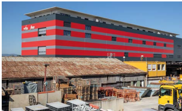
La nouvelle Halle Kammacher s'ajoute en mars 2021 à la première Halle inaugurée en 2011. Ces 2 constructions ont été édifiées sur un terrain pollué par des dépôts et le stockage de déblais provenant de l'incendie du magasin Grand Passage. Ces terres ont été traitées lors des excavations. Photo David Mayenfisch Capt3
