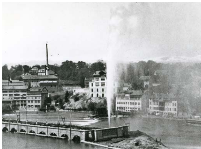
Construction du bâtiment des forces motrices et le premier Jet d'eau, 1887
